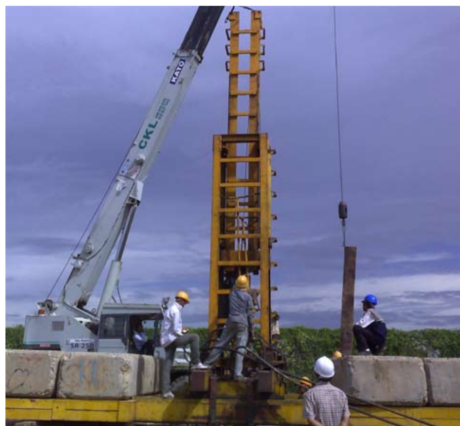
02 | PilingforfoundationatGS2-PhnomPenh
